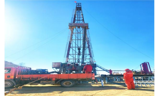
11月20日14时，公司山西临兴煤层气勘查项目第5口定向井开钻，该井井深设计2500余米。截至11月21日5时，该井实时优化钻井液配比方案，在地层漏失较大的工况下仅用15小时完成了230米的一开钻进。目前，项目各项工作进展高效、安全、有序。
